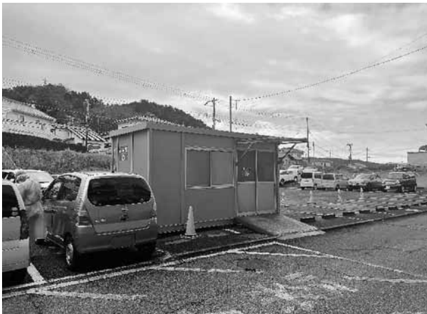
写真1 発熱外来コンテナハウス
