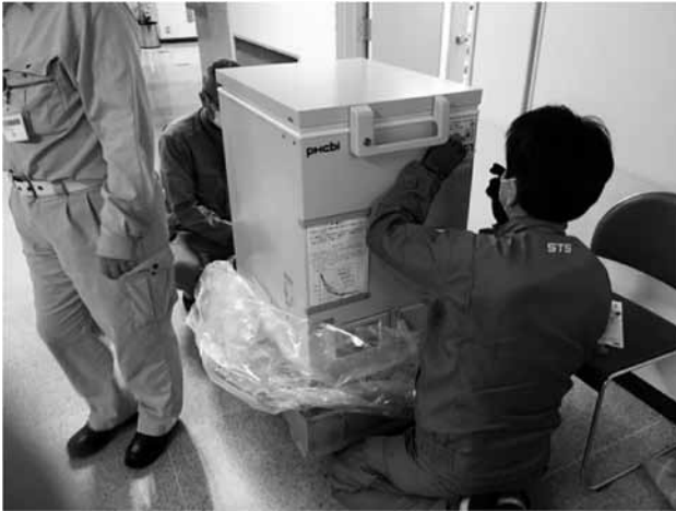
超低温冷凍庫設置工事風景
